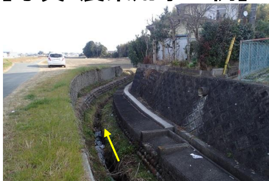
7.6k 大井堰_堤内地水路
