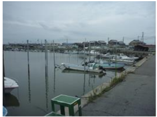
下流部の係留施設（外集水池）
