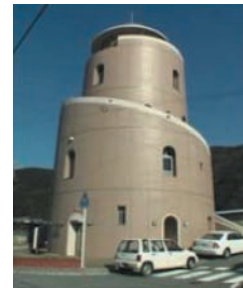
津波避難タワーの整備
