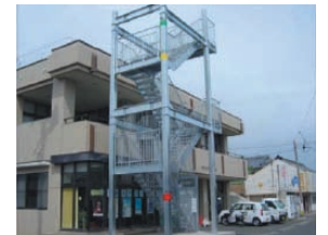
外付階段整備
