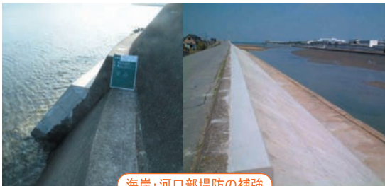
海岸・河口部堤防の補強
