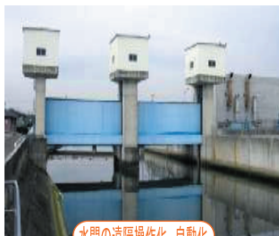
水門の遠隔操作化、自動化
