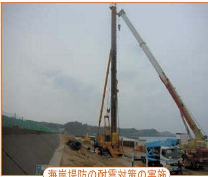
海岸堤防の耐震対策の実施
