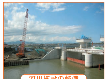
河川施設の整備
