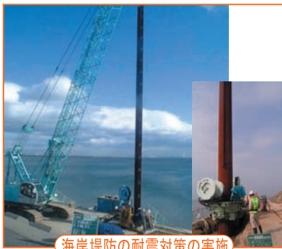
海岸堤防の耐震対策の実施
