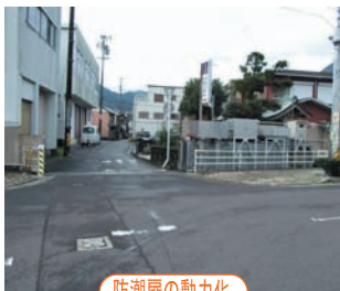
防潮扉の動力化
