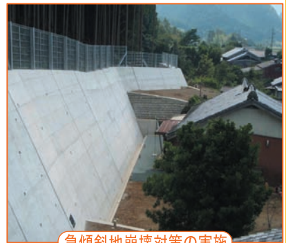
急傾斜地崩壊対策の実施
