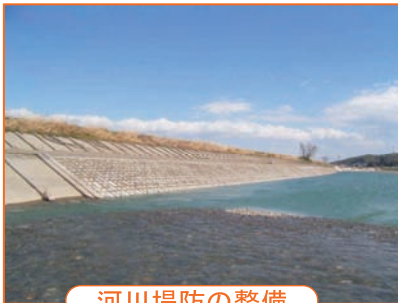
河川堤防の整備
