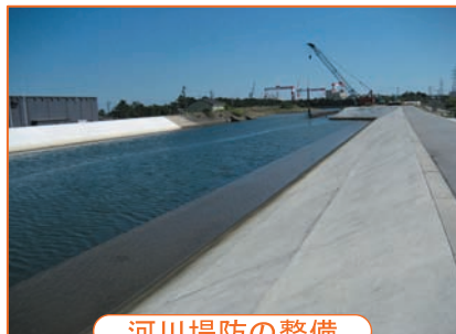
河川堤防の整備
