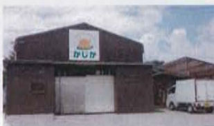
解体処理施設の整備
