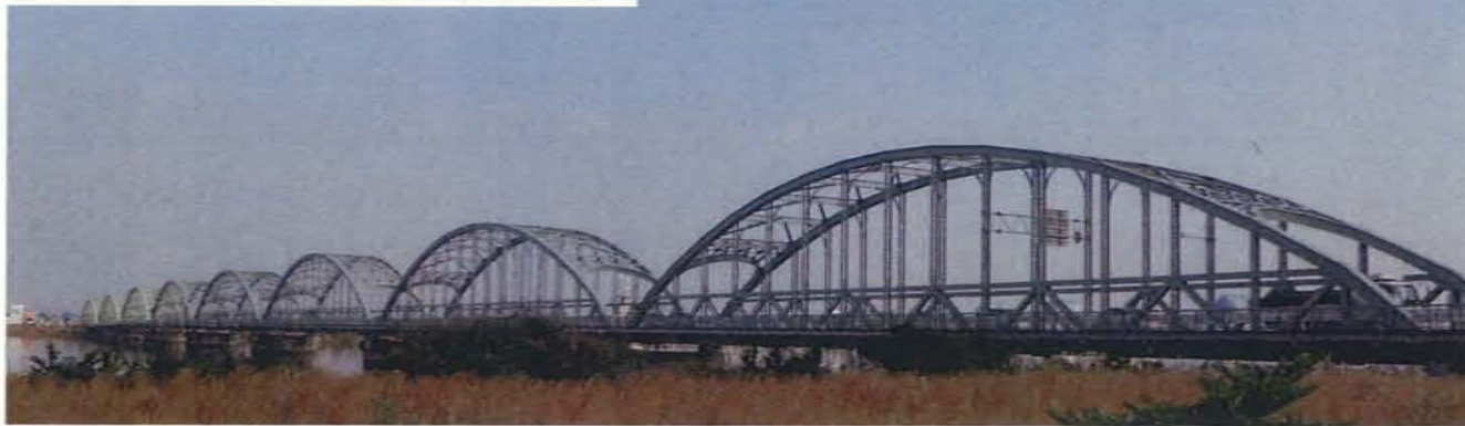
<中堤上流からの全景> *昭和9年度竣工（79年経過）
