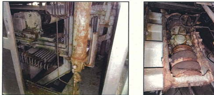
② 設備の劣化状況(汚泥脱水機)
