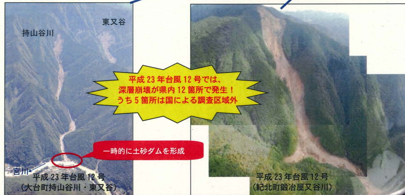
三重県における深層崩壊の発生事例
