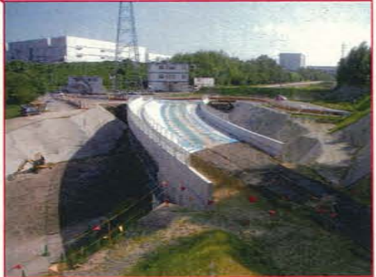
四日市市垂坂付近施工状況（橋梁工）（H26年度供用予定）
