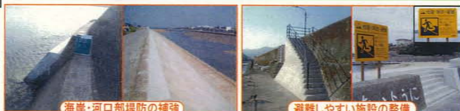
海岸・河口部堤防の補強
