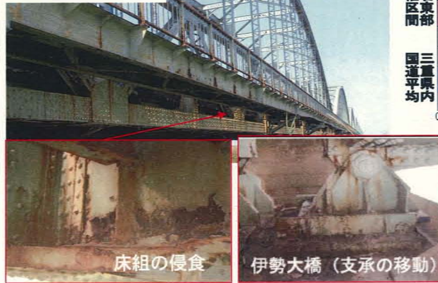
<補修塗装工事前の状況>
