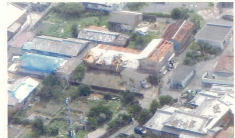
上空から見た被害家屋等〔三重県撮影〕
