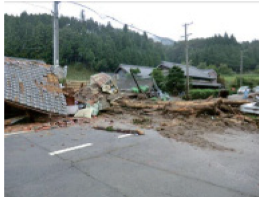
山腹崩壊（表層）による被害
