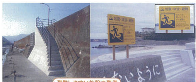
避難しやすい施設の整備
