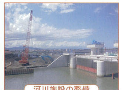
河川施設の整備
