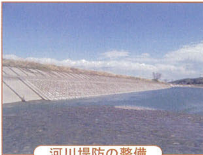
河川堤防の整備
