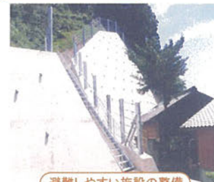
避難しやすい施設の整備
