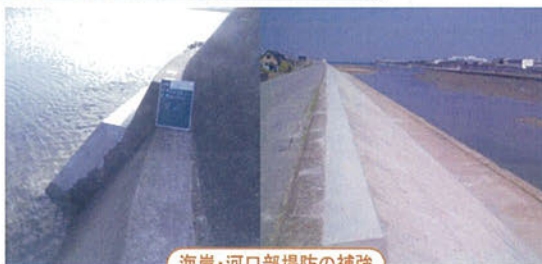
海岸・河口部堤防の補強
