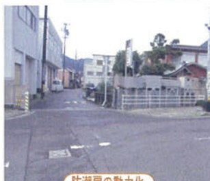
防潮扉の動力化
