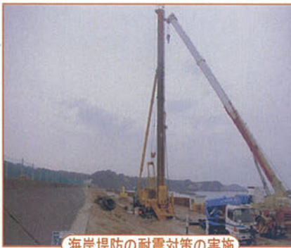
海岸堤防の耐震対策の実施
