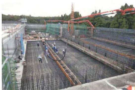
沈殿池コンクリート打設状況
