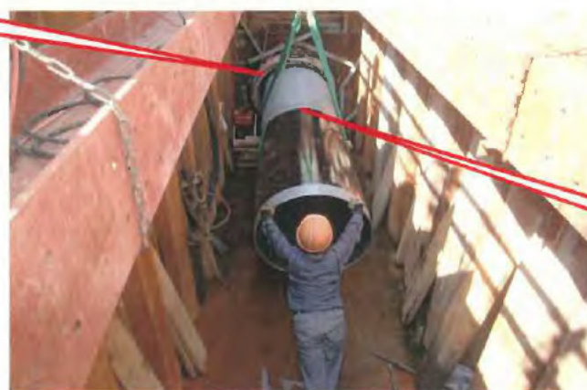
配水管（PC管）更生工事
