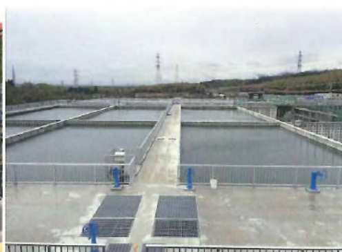
沈殿池完成後
