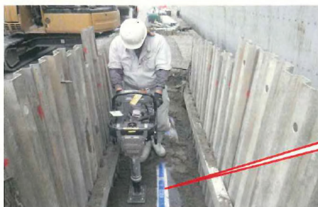
配水管複線化工事（φ300 耗配水管）
