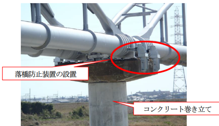
耐震化を行った鈴鹿川第2水管橋
