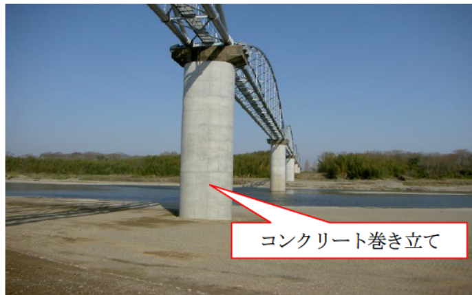
耐震補強工事の実施状況 〔宮川水管橋下部工〕
