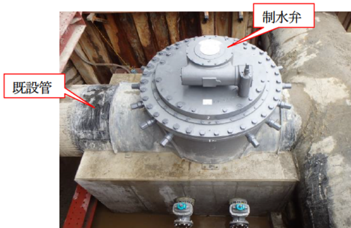
不断水工法による制水弁の設置状況 〔内径1350mm制水弁取替工事（四期・下深谷部）〕
