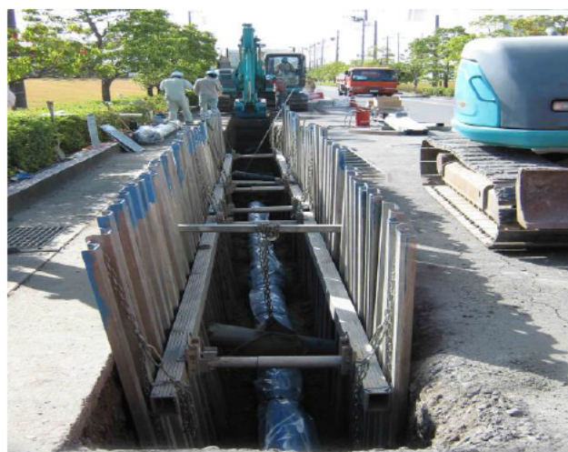
管路布設替えの状況
