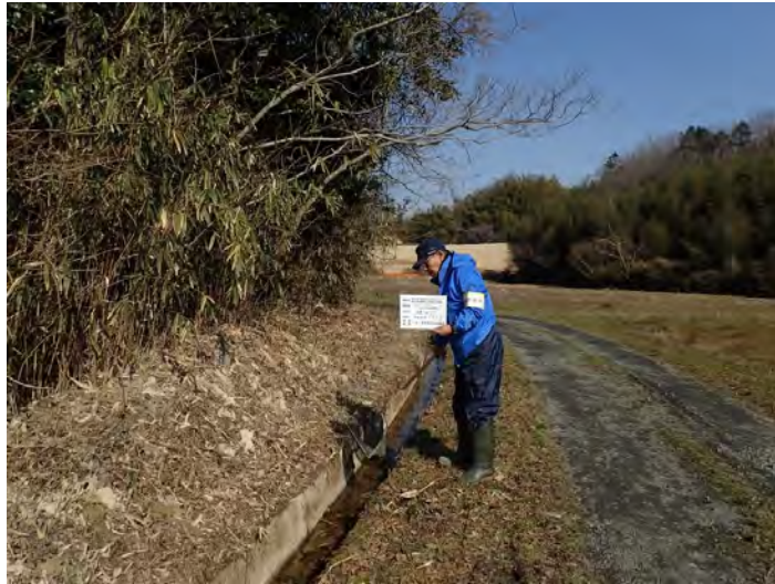
写真 2-4-4 調査風景 平成 28 年 3 月 3 日
