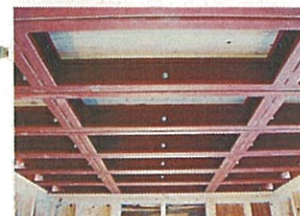
予め工場で用意されたパネルを、現場で組み立てる。
