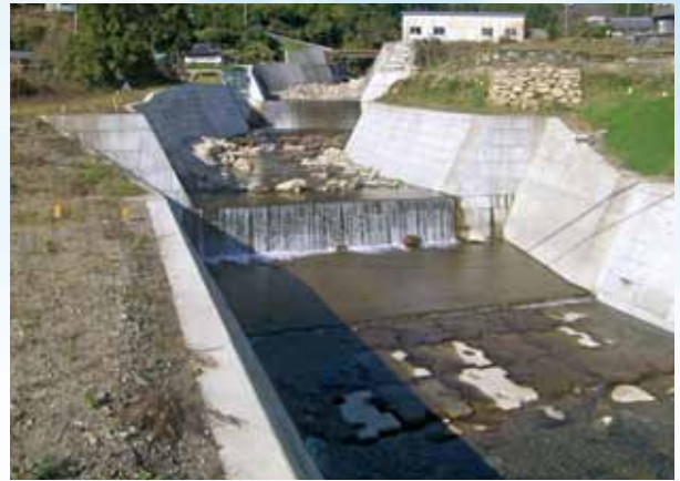
紀伊半島大水害からの復旧（井戸川（熊野市））
