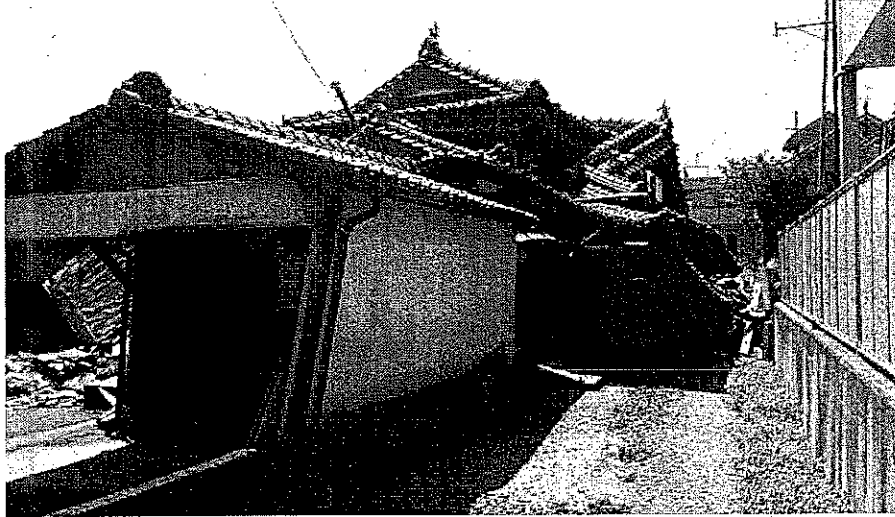
家屋倒壊状況
