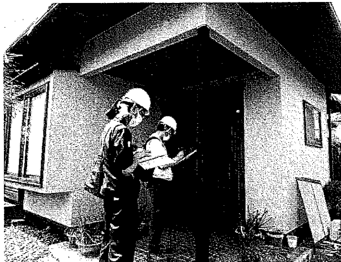
応急危険度判定実施状況
