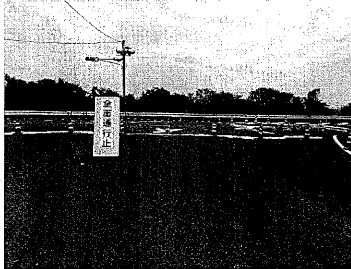
市内道路は至る所で被害が発生し通行止め
