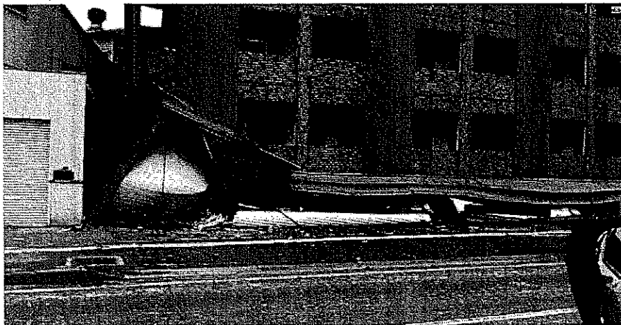
1階が倒壊したマンション
