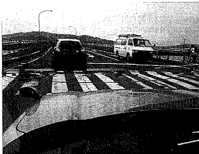
橋梁ジョイント部分目地の段差
