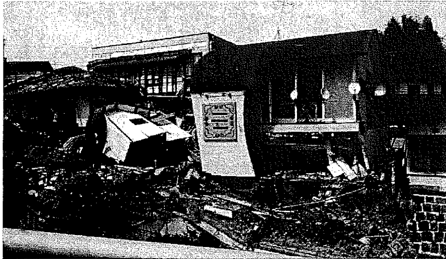
家屋倒壊状況
