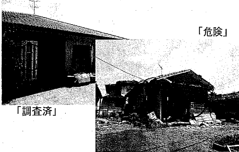
応急危険度判定が実施された家屋
