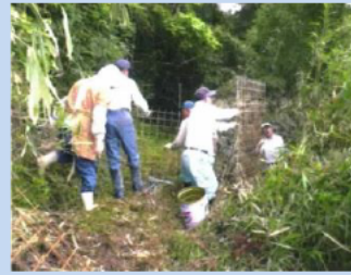
出会い作業で集落全体に柵を設置
