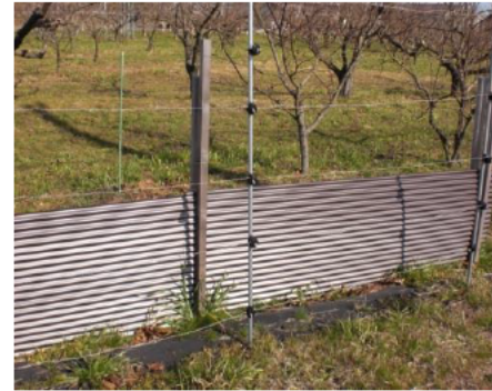
電気柵+トタン
