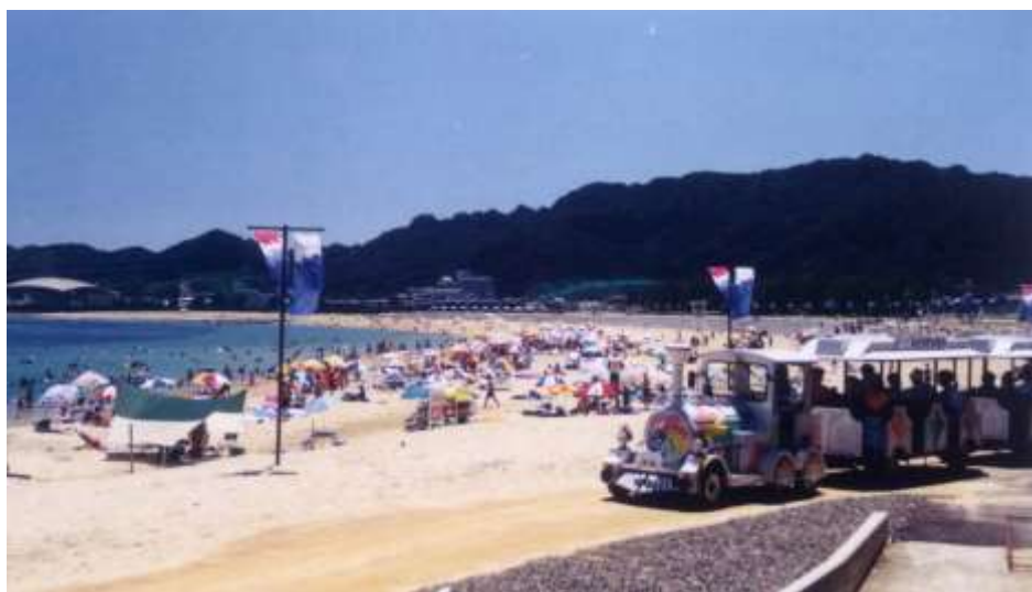
緩傾斜護岸（那智勝浦海岸：平成 11 年撮影） 出典：和歌山県資料
