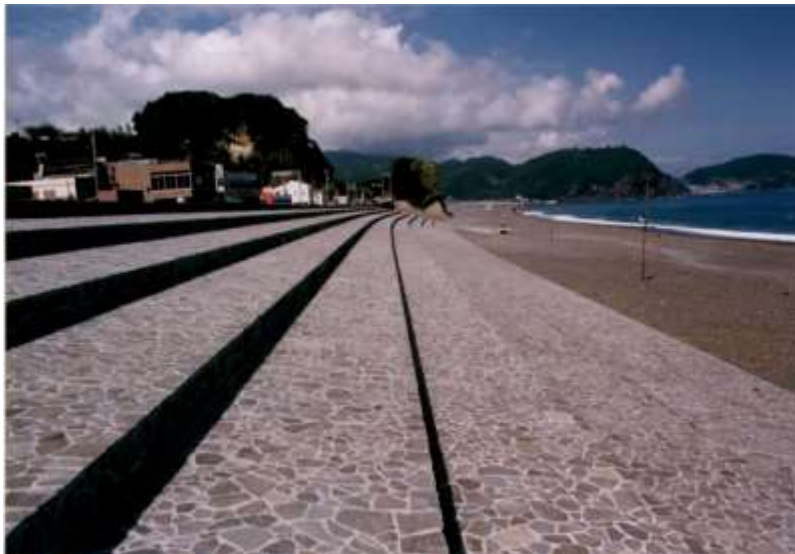
緩傾斜護岸（熊野海岸 有馬地区） 出典：三重県資料
