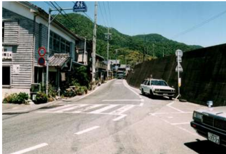
堤防によるアクセスの遮断（贄浦）
