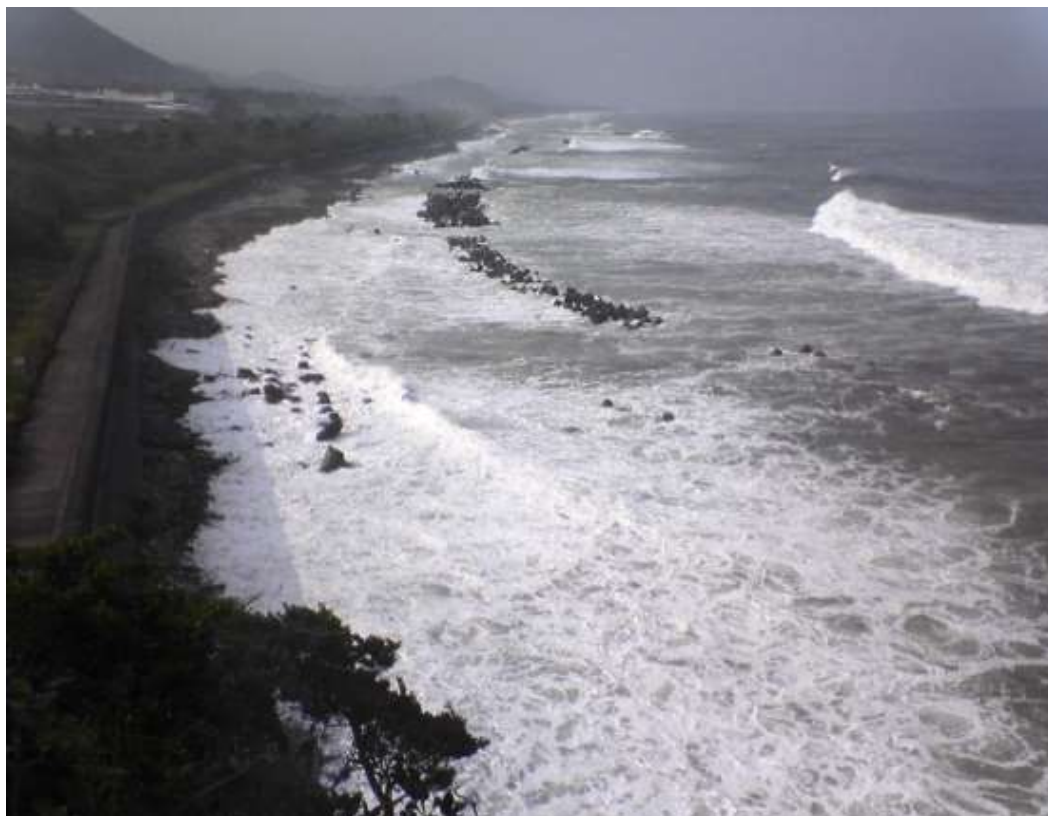
侵食後（平成 27 年 9 月撮影）
