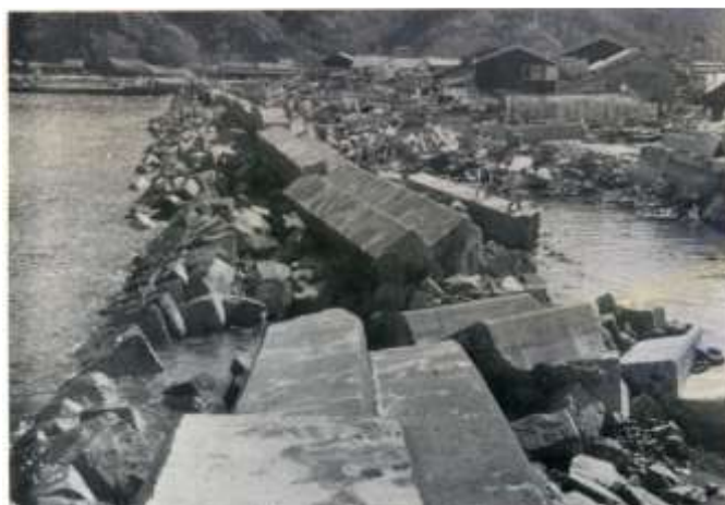
ずたずたになった港湾施設（北牟婁郡長島港）
