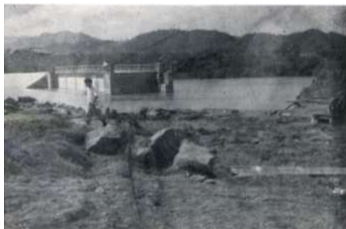
一般国道の流失（熊野市志原地内）
