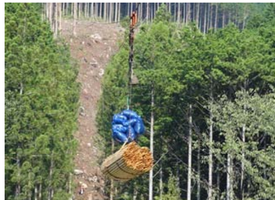
架線を利用した防護柵資材等の運搬
