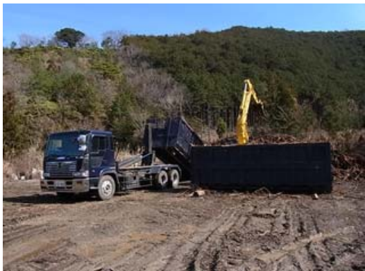
中間土場での積み込み作業
