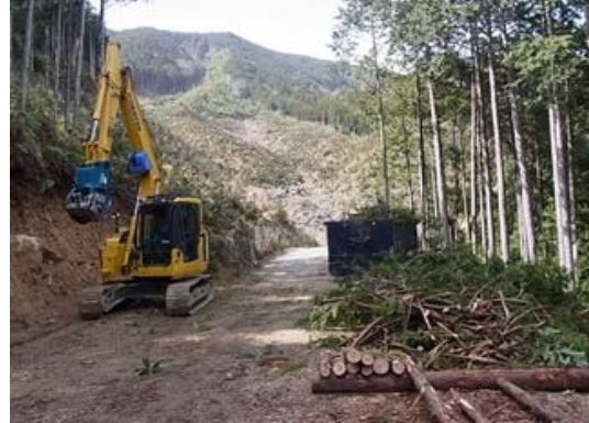
伐採現場の枝葉と設置された積込コンテナ
