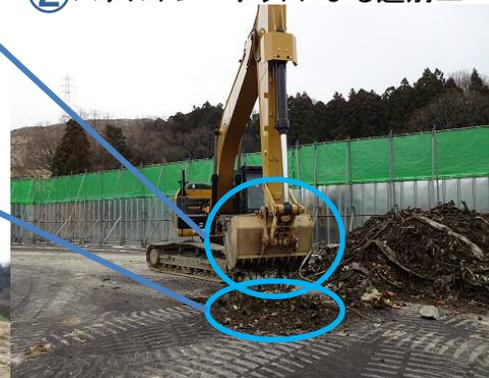
「はさみ」により固結した廃棄物をほぐし、また粗大廃棄物を除去することにより、スケルトンバケットの目詰まりを防止。
