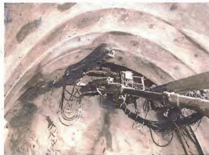
掘削工(削孔状況)
