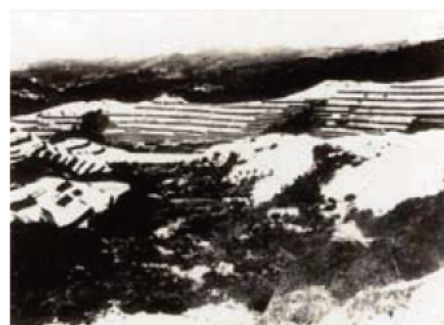
(工種) 積苗工粗朶伏工 昭和8年施工
