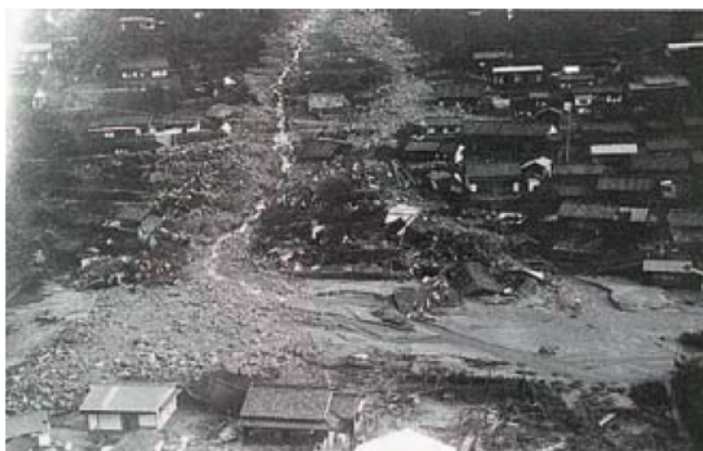
小浜川土石流（尾鷲市賀田町）
