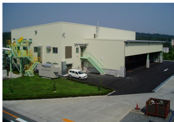
RDF貯蔵施設
