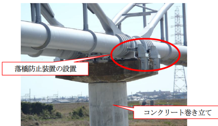
耐震化を行った鈴鹿川第2水管橋
