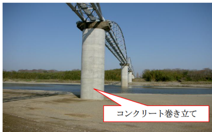
耐震補強工事の実施状況 〔宮川水管橋下部工〕
