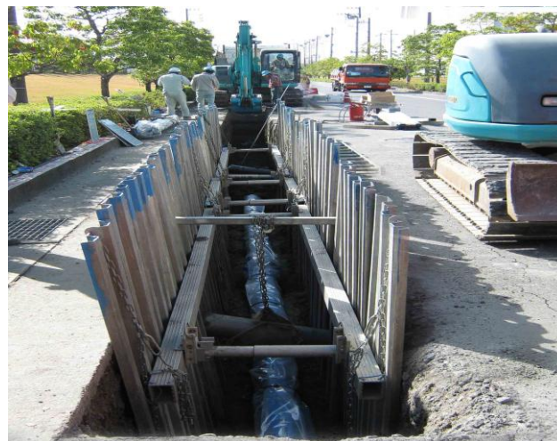
管路布設替えの状況
