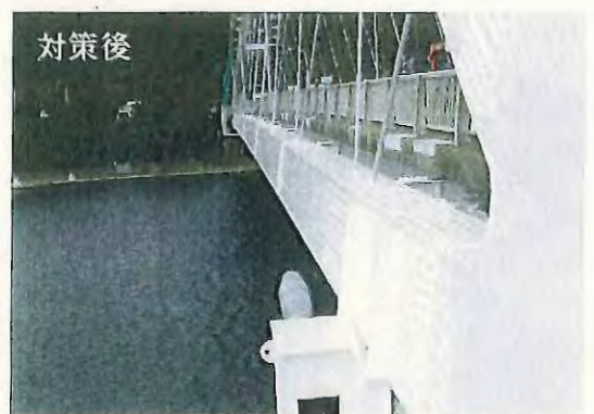
橋梁の劣化を防止するため、全面塗装塗替を行った
