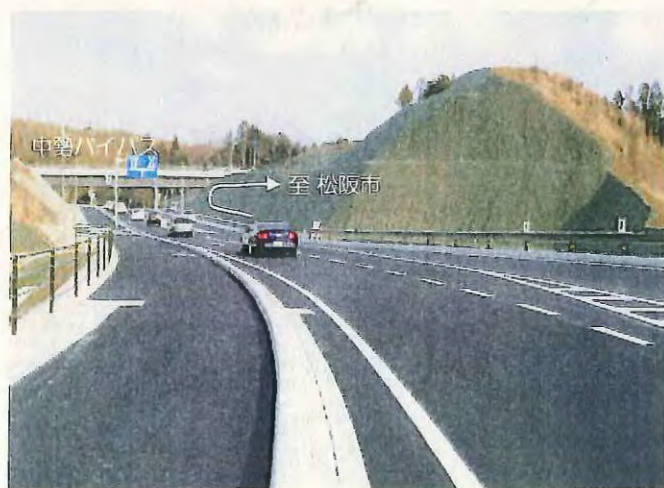
主要地方道久居河芸線 雲出野田バイパス(津市) (平成27年2月8日 0.8km供用)
