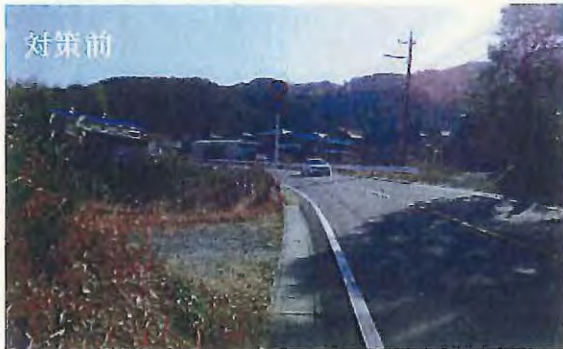
歩道がなく、通学生徒等が危険な状態である
