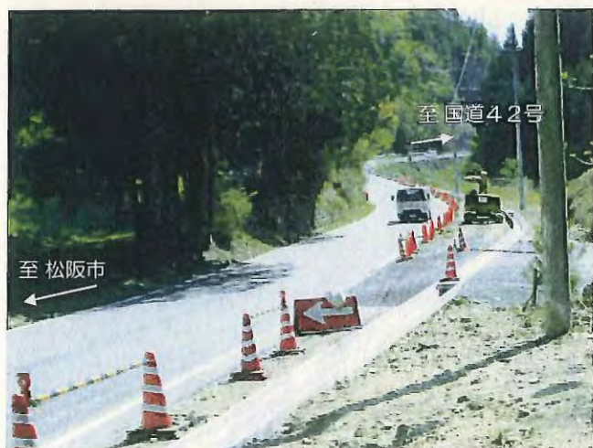
一般国道368号 桜峠拡幅(多気町)
