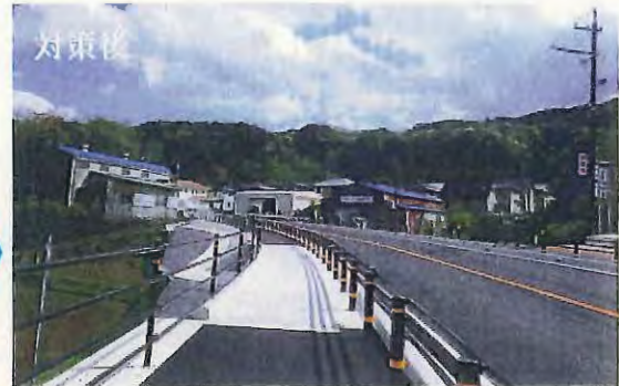
通学生徒等、歩行者の安全確保を図るため、歩道を整備した (写真は部分供用箇所/事業継続中)
