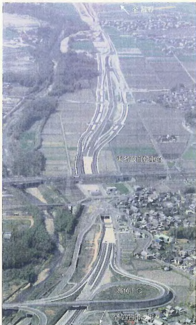
一般国道477号四日市湯の山道路(四日市市～菟野町) 高角IC～県道四日市菟野大安線(通称:ミルクロード) (平成26年5月24日 4.4km供用)
