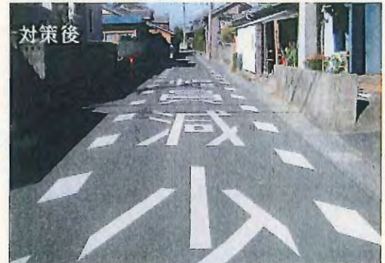
通行車両の速度を抑制するため、減速マーク・幅員減少の路面標示を行った
