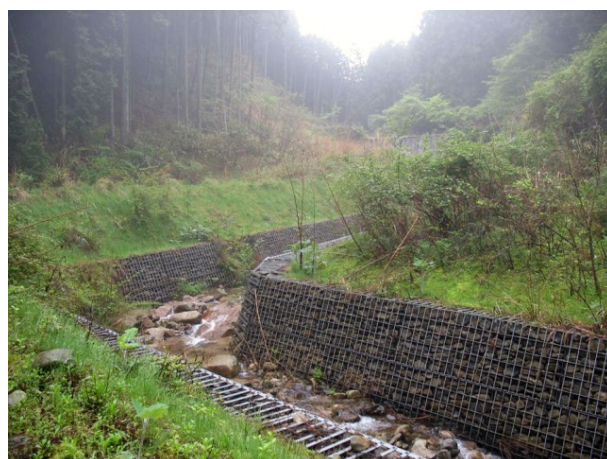
水土保持施設の整備（鋼製護岸）
