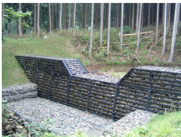
水土保持施設の整備（鋼製ダム）
