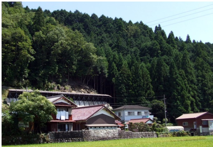
落石防護壁工 (熊野市)
