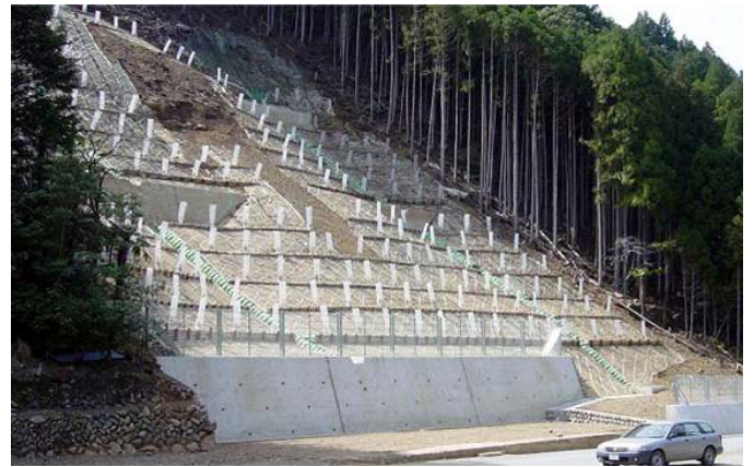
復旧後 (災害関連緊急治山事業)
