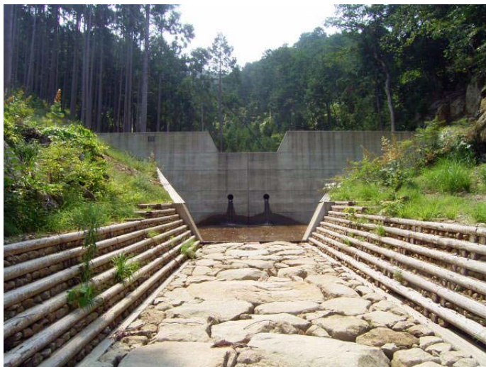
木製護岸工 (熊野市)
