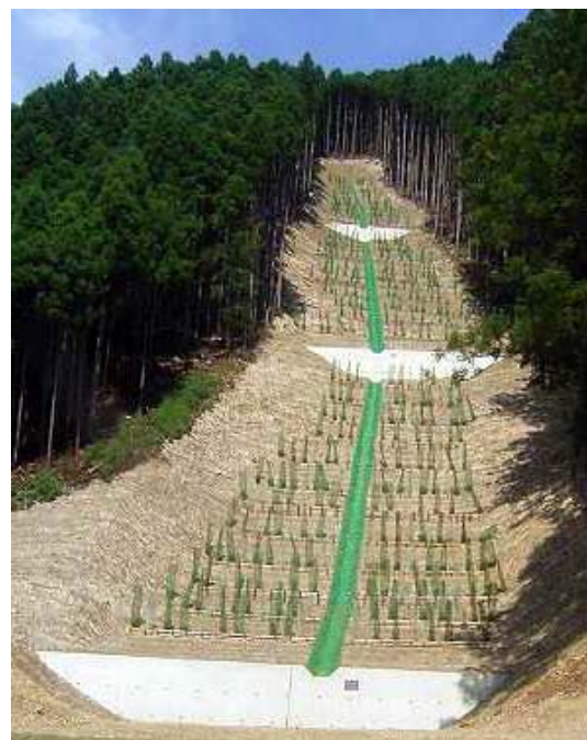
復旧後 (治山激甚災害対策特別緊急事業)
