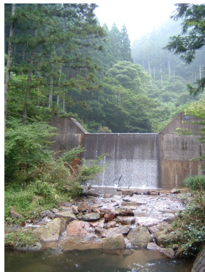
コンクリート谷止工
