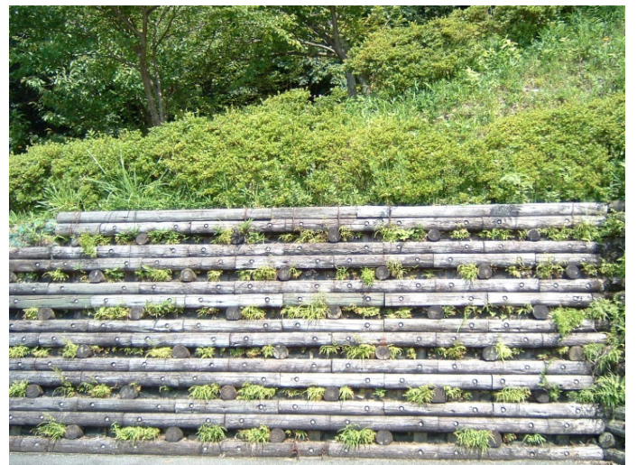
木製土留工 (伊勢市)
