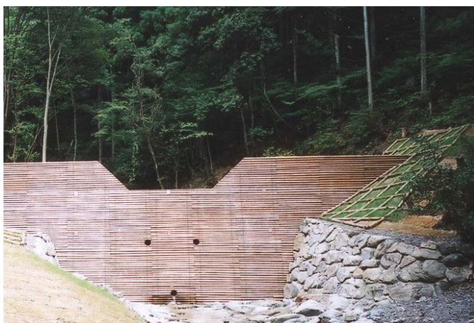
残存型枠 (松阪市)
