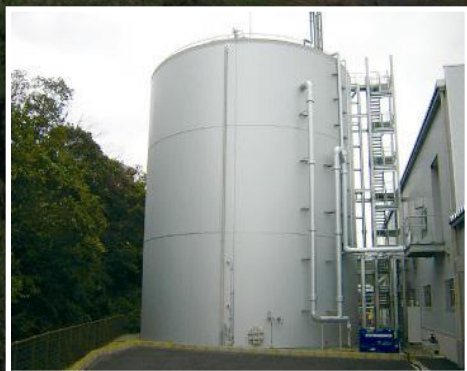
▲メタン発酵槽
