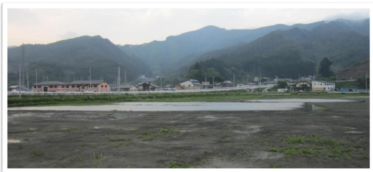
復興基盤整備事業を新規に実施する予定の下野地区（上閉伊郡大槌町。現在は事業着手済）
