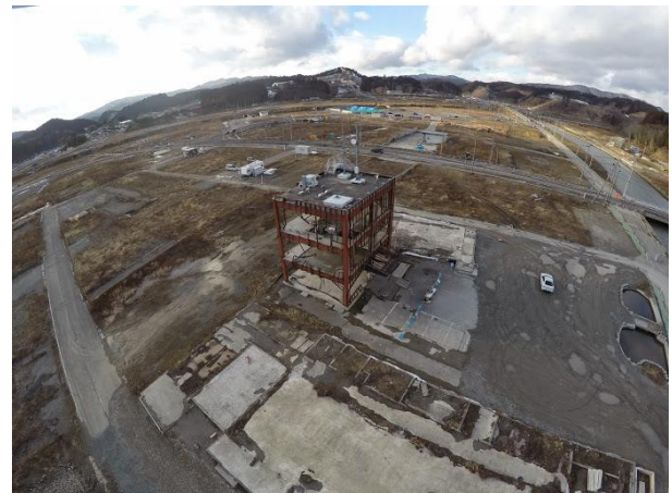
防災対策庁舎
