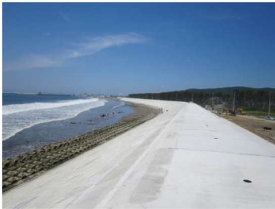
長浜地区海岸（石巻市渡波） TP+6.0m （平成27年度中に完成）
