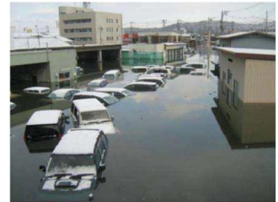
浸水した事務所
