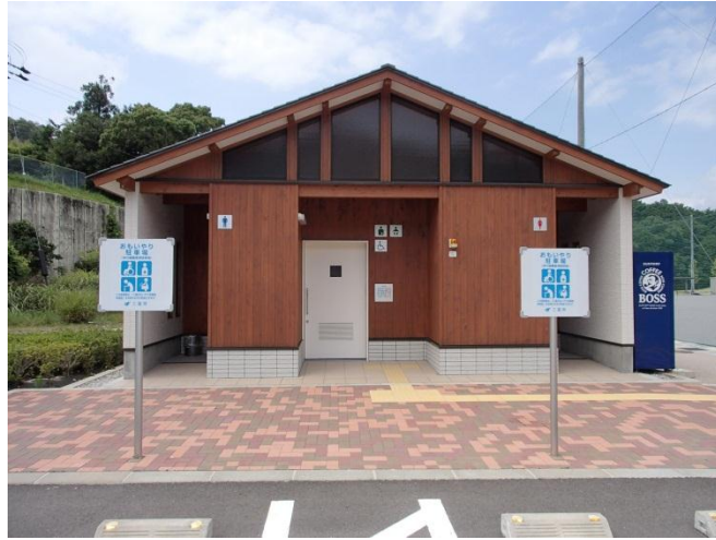
多機能トイレと「おもいやり駐車場」が整備された熊野灘臨海公園
