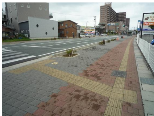
幅の広い歩道（県道久居停車場津線）
