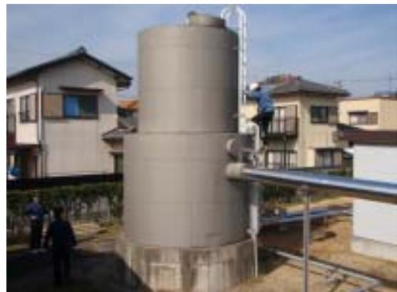
写真1 ガス分離設備でのメタン測定
