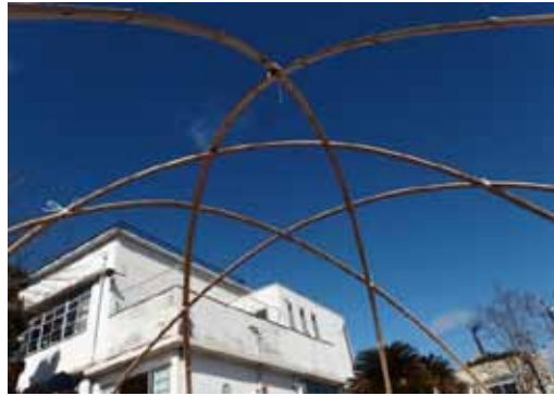
枠組みが完成しました
