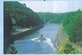
深谷水道 大王町と志摩町の間にある英虞湾(あごわん)と太平洋を結ぶ長さ660mの人工の水路。漁船の便と海水の動きを良くするために昭和七年に作られました。
