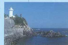
安乗崎灯台 芝生公園の広がる岬の先端に広がる岬の先端に建つ白亜の四角い灯台。
