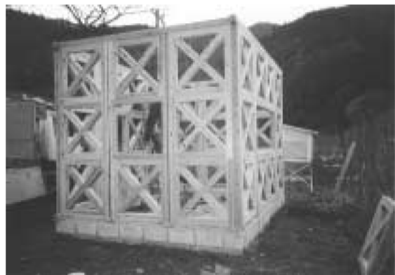
写真-5 試作建物の組立て状況
