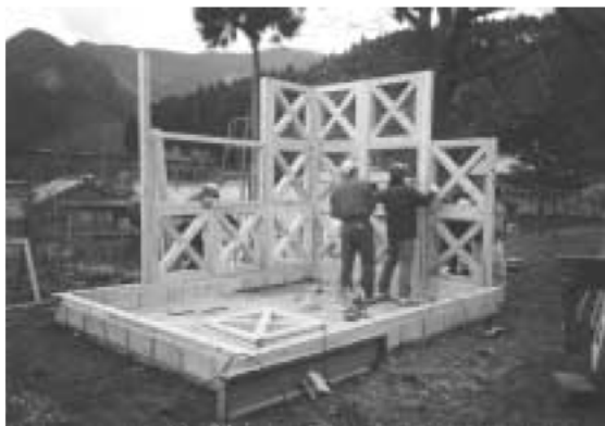
写真-4 試作建物の組立て状況
