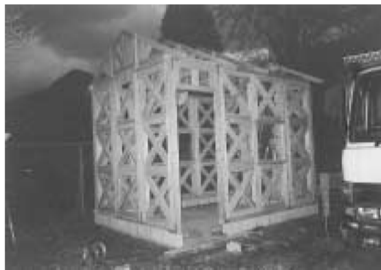
写真-6 試作建物の組立て状況
