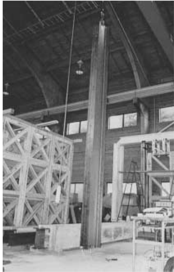
写真-2 H形鋼試験体
