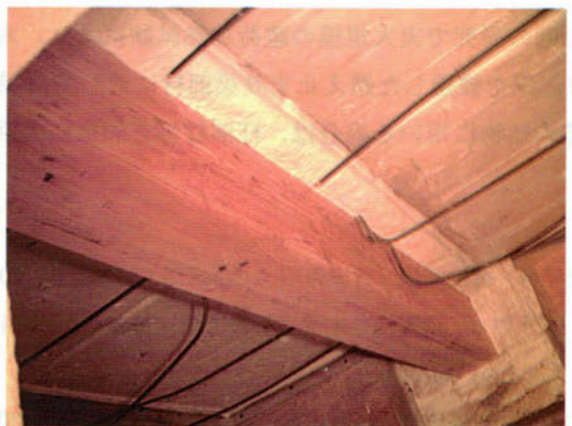
炉内へ設置した状況
