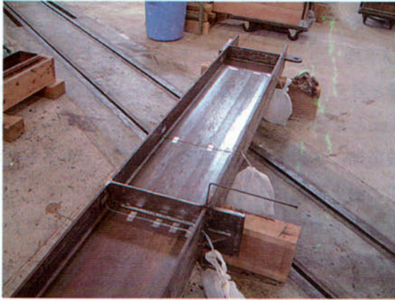
プライマー塗布した鋼材
