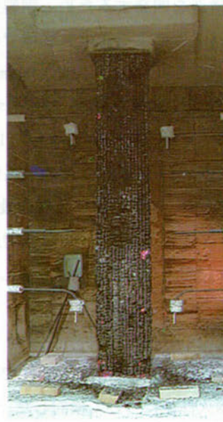
試験後の状況
