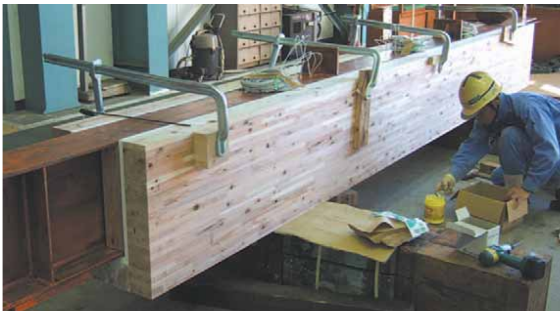
写真-1. 製作状況
