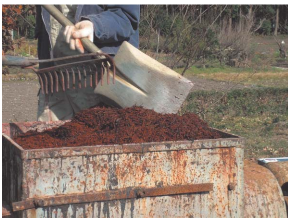
③ アスファルト乳剤と木質廃材との混合
