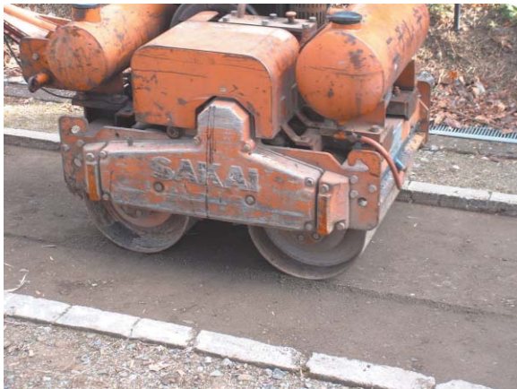
① 路盤整備
