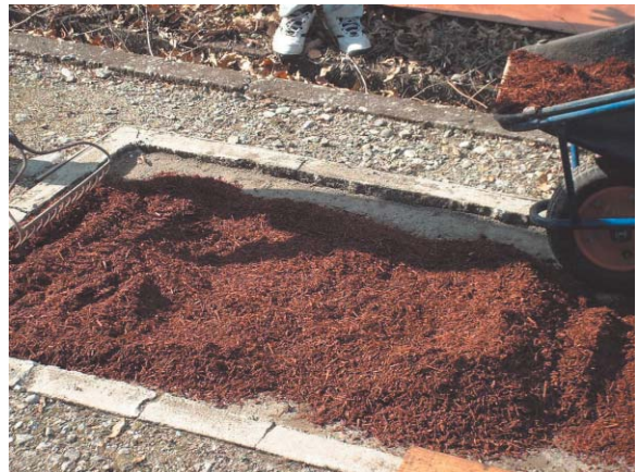
④ 混合木質廃材の敷設
