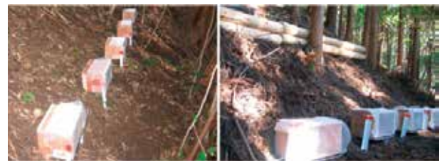
写真-1. 土砂受け箱、木柵設置状況
