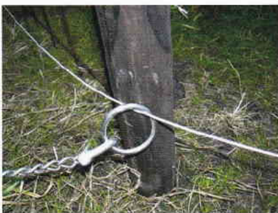
鋼線とリングの連結状況
