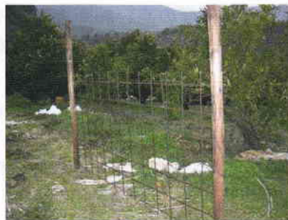
杭とワイヤーマッシュの設置状況
