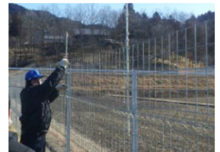
アルミテープの代わりに電気線をらせん状に巻き簡素化
