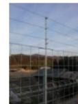
既存のフェンスに加えることでサルも防げる柵に(伊賀市子延地区)
