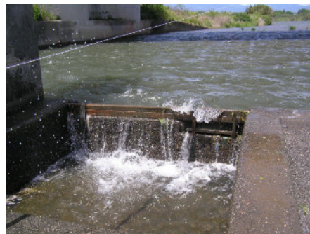
図 1. 上流端が厚板でかさ上げされ、機能していない魚道（小野江頭首工）
