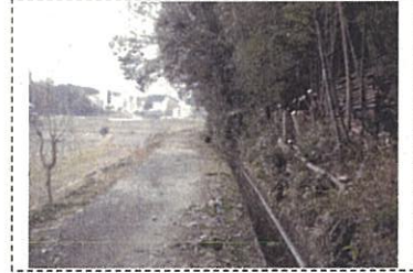
整備後の竹林 (小山田地区 平成27年2月撮影)
