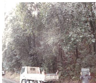
事業着手前(両尾町地内) 平成27年2月23日撮影
