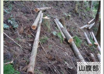
伐倒木を利用した土砂止の設置
