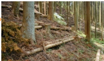
伐倒木を利用した土砂止の設置
