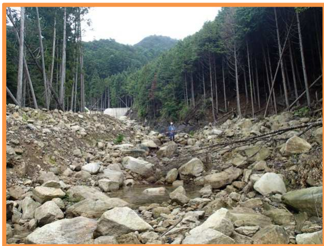
事例 2 溪流内に異常堆積した土砂
