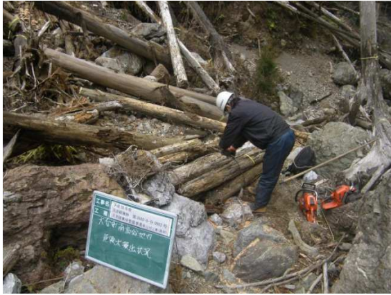
1. 危険木 搬出作業状況
