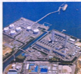
46.4%を誇ります。3号機・4号機は、ガスタービン入口のガス温度を1,100°C級から1,300°C級に高くし、高温排気ガスを排熱回収ボイラで有効利用することにより、従来の発電方式に比べて高い、熱効率53.9%を誇ります。火力発電所や電力館を見学し、クリーンで効率的なエネルギー利用について学ぶことができます。
