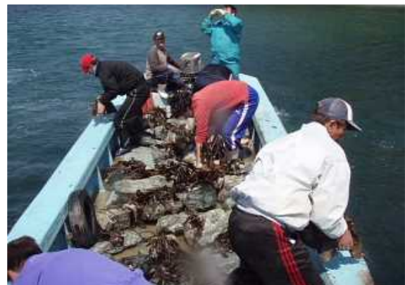
アラメ付自然石の投入作業
