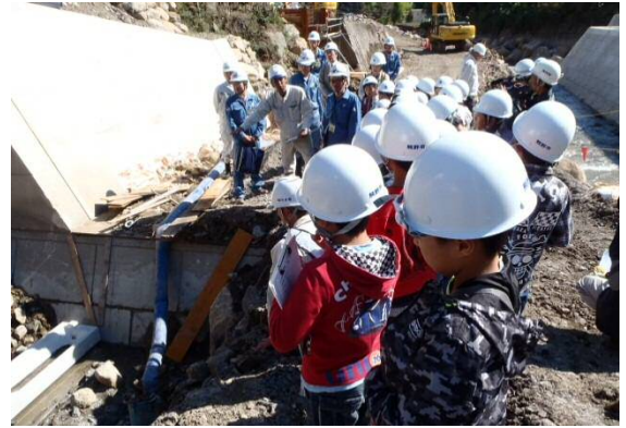
ブロック積護岸の作業状況を見学しました。
