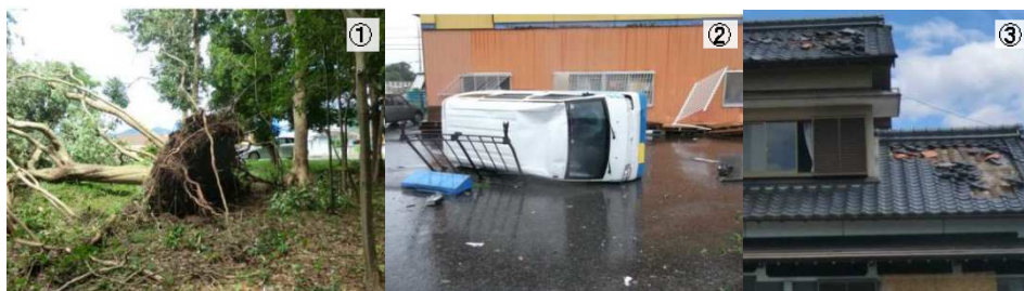
写真 被害状況 (平成26年8月9日の突風による被害)
