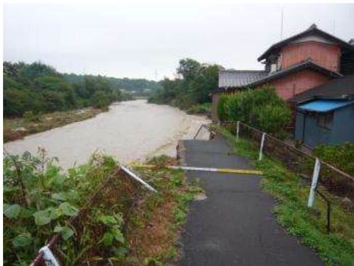
菰野町田光川付近
