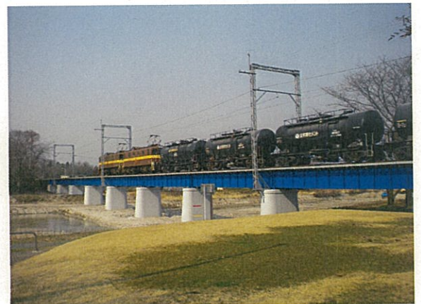
【同橋梁修繕後】
