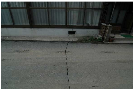
写真2 地割れにより、伝統的構法ではないコンクリート布基礎に亀裂が入った例
