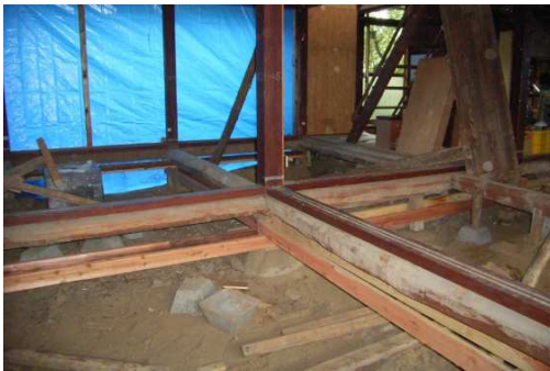
写真1 根がらみを足固めの下に取り付けた例
